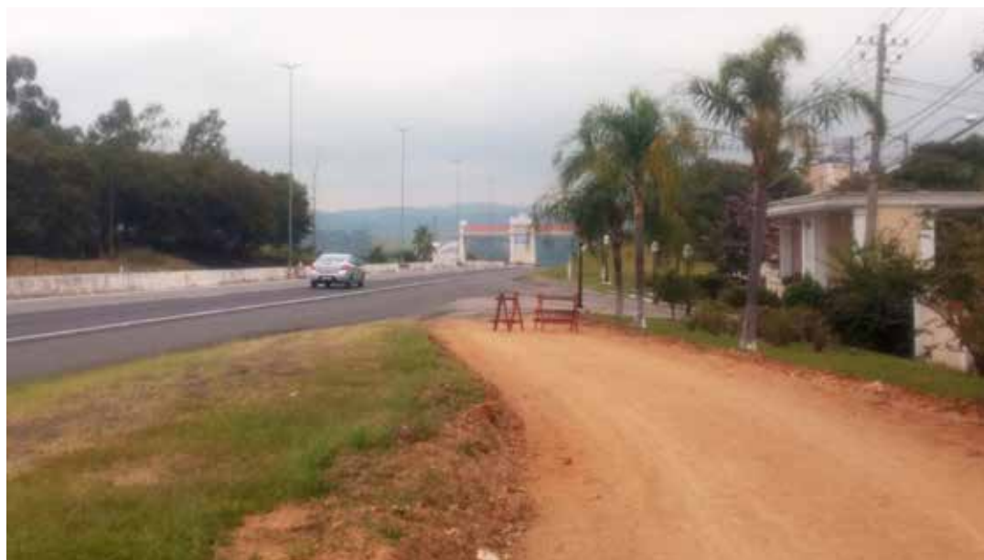
À esquerda, a rodovia duplicada. À direita, acesso ao Paraíso 2, que só pode ser feito pela pista; ao fundo, portal de entrada da cidade
