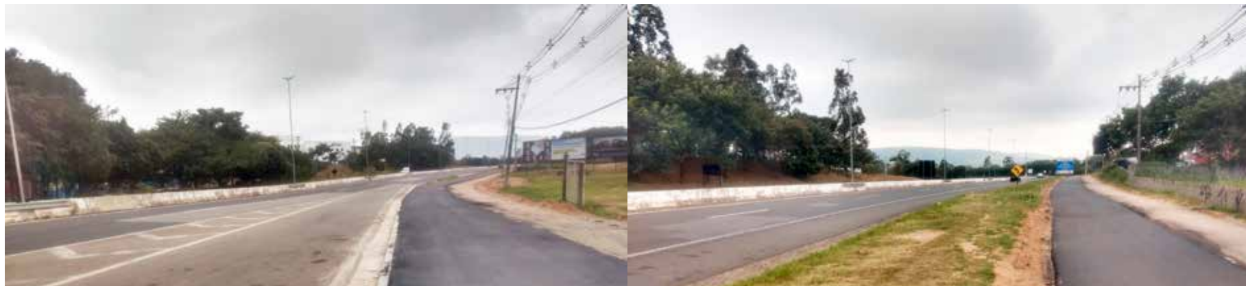
Está sendo aberta uma via paralela à rodovia
