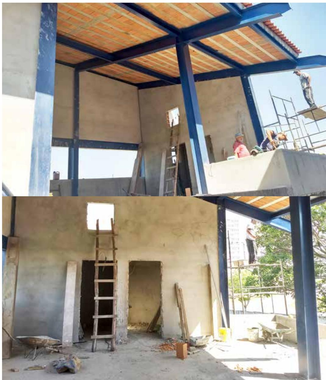
As obras de ampliação da sede da Associação dos Engenheiros e Arquitetos de Itu prosseguem. Após a conclusão da colocação do reboco, os passos seguintes devem envolver o fechamento com vidros, a estrutura elétrica e instalação de pisos e louças. Concluídas essas etapas, a
